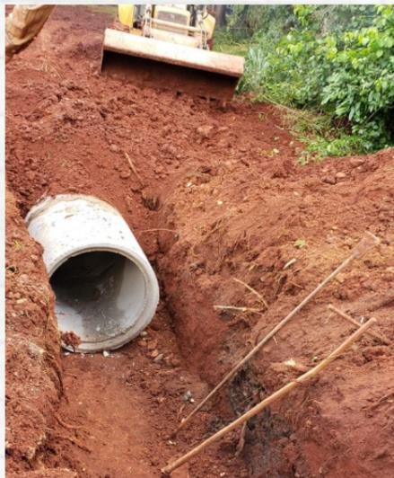
*Obra de escoamento pluvial.*
