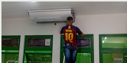
Instalação de aparelhos de ar condicionado.
