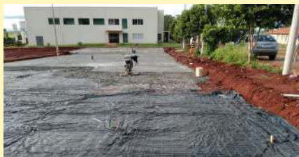
Construção do estacionamento.
